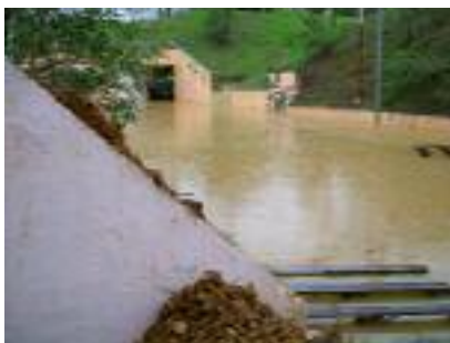
Figure 17 : Hauteur d'eau atteinte sur le site
