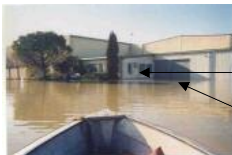
Figure 15 : Vue extérieure du niveau d'eau atteint sur le site
