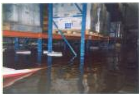
Figure 14 : Niveau d'eau atteint dans les cellules de stockage
