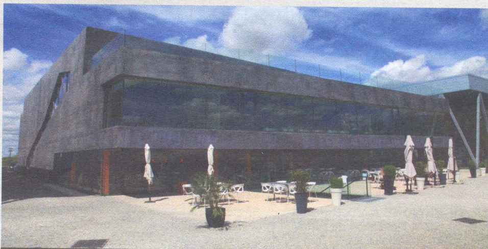
LE COMPLEXE DE FUTSAL DE ZINEDINE ZIDANE À AIX-EN-PROVENCE (ARCHITECTE CHRISTOPHE GULIZZI), L'UN DES 100 BÂTIMENTS DURABLES MÉDITERRANÉENS LABELISÉS PAR LE PRIDES.
