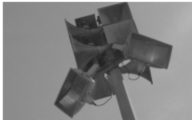
▲ Ci-dessus : sirène du réseau national d'alerte (à gauche) et sirène PPI (à droite)
