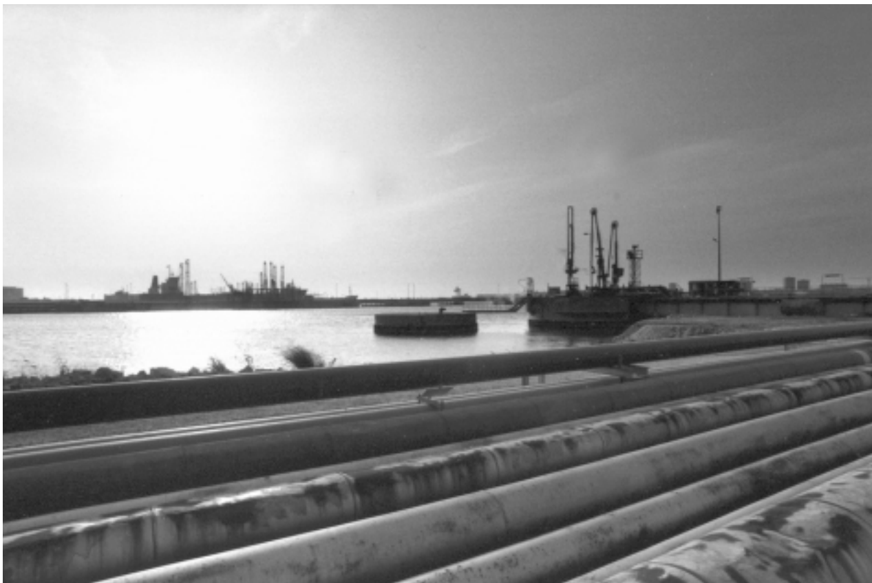
▲ Des canalisations sur le port, hier ...
