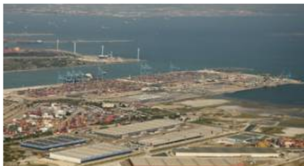
Distripport et les terminaux à conteneurs de Fos-sur-Mer. Crédit photo : GPMM.
