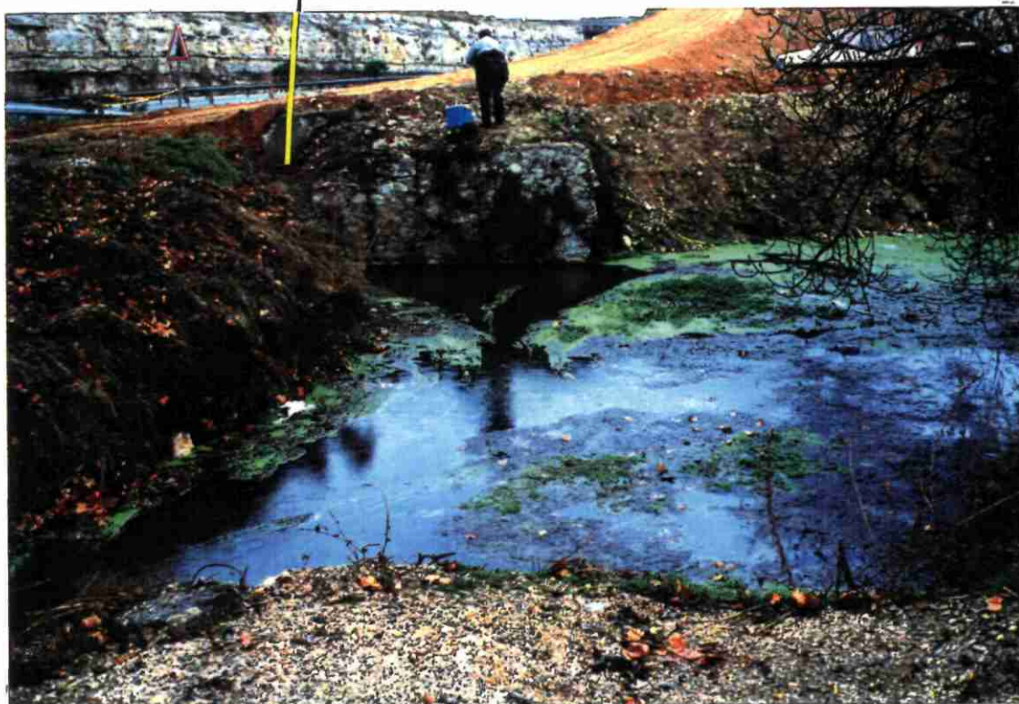
Exutoire du pluvial de l'échangeur
